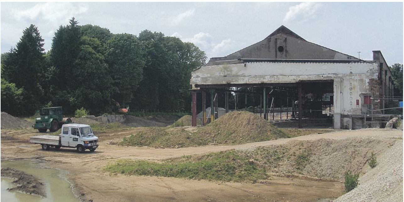
Bauland auf Industriebrache: Auf dem Gelände der früheren Papierfabrik Euler in Bensheim sollen 320 Wohnungen entstehen.
